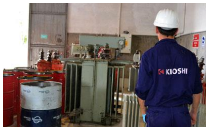
Foto 1 Personal de Kioshi S.A. iniciando la descontaminación de equipos eléctricos en Gualeguaychú, Enre Rios, Argentina.
